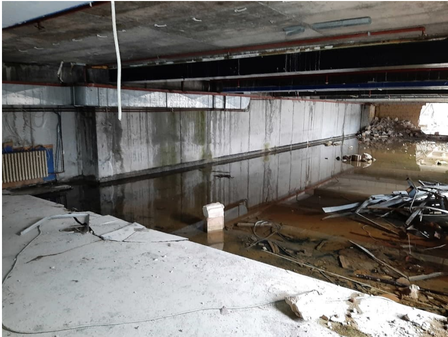
Foto 9: Innenansicht der westlichen Kelleretage.
