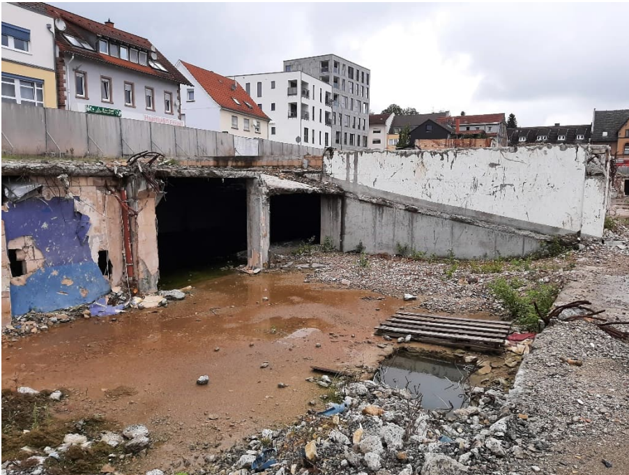
Foto 8: Außenansicht der westlichen Kelleretage (Langer Areal).
