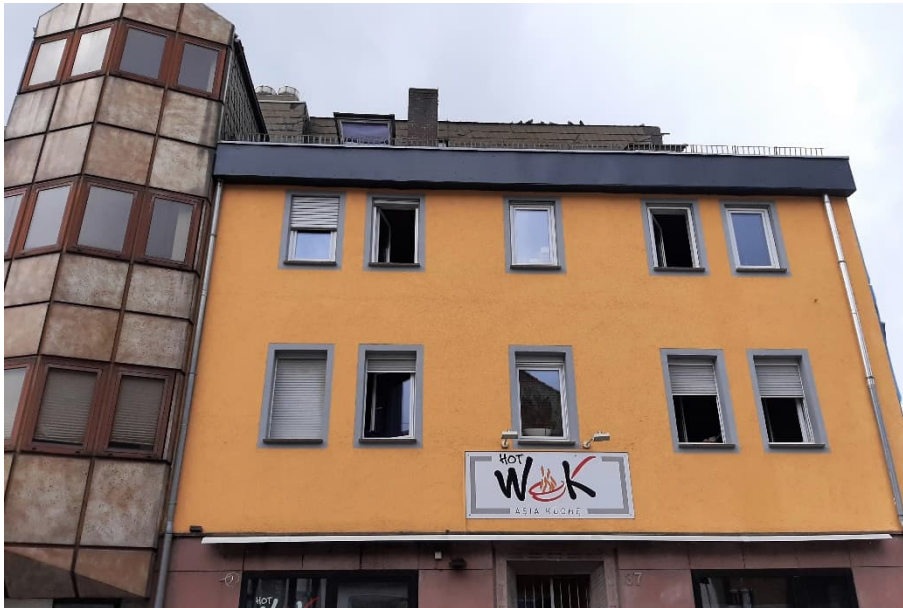
Foto 1: Links das alte Treppenhaus des ehemaligen Kaufhaus Langer und rechts die Fassade der Obertorstraße 37.
