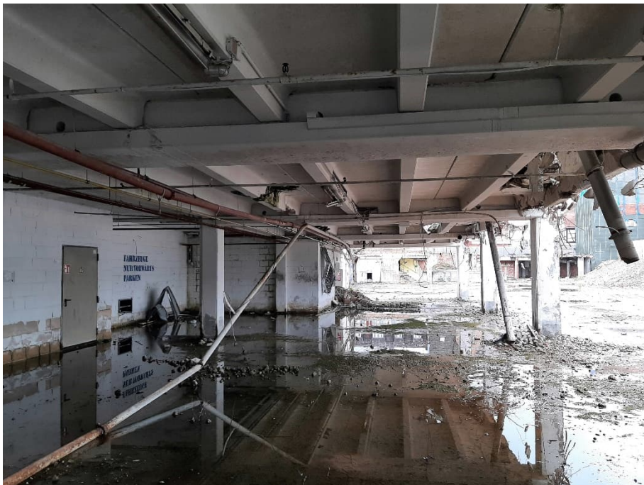
Foto 10: Innenansicht mittlere Kelleretage.
