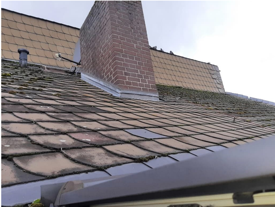
Foto 3: Detailansicht des Daches der Obertorstraße 37.
