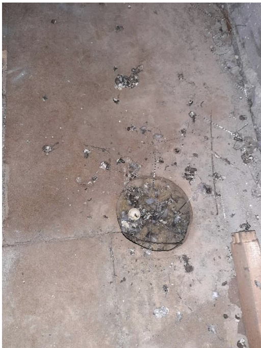
Foto 6: Straßentaubennest auf dem Dachboden.
