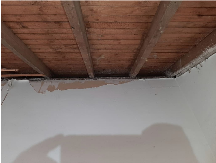
Foto 13: Dachschräge des Bestandstreppenhauses.
